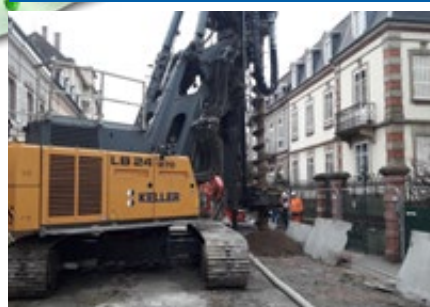
> Ouverture du chantier
